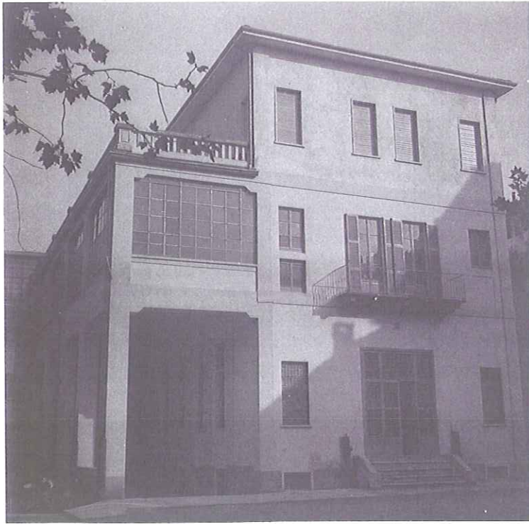
30 Ottobre 1949 - Il pensionato ricostruito dopo la distruzione della guerra
