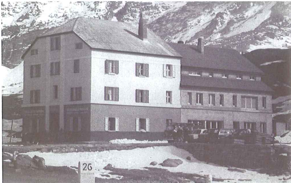
1976 - La casa al Passo Gavia dopo i lavori di ampliamento.
